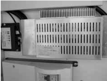
Laderegler im Kleiderschrank an der Wand
