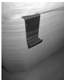
Befestigungshalterungen platzieren
