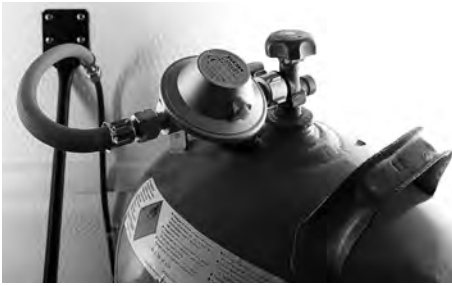
Anschluss des Gasreglers an der Gasflasche
